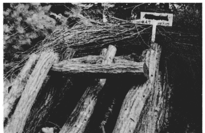
写真-4 野伏せB区の伏せ組み方
