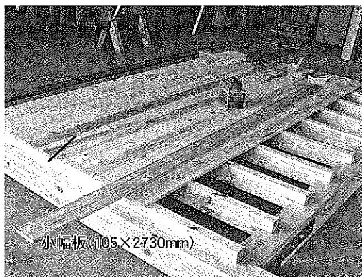
写真一3 面材料として用いた小幅板
