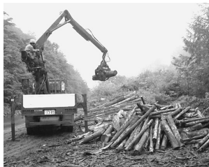
写真-3 (残材積込) ロードークレーン付10tトラック 最大積載量：10,000kg
