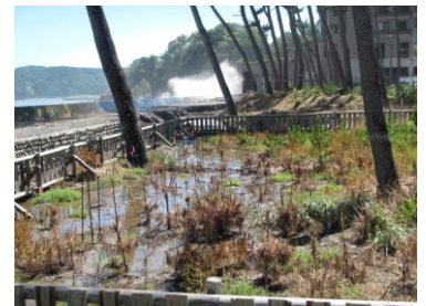
浪板試験地・海水流入、滞水状況 (平成 28 年 9 月)
