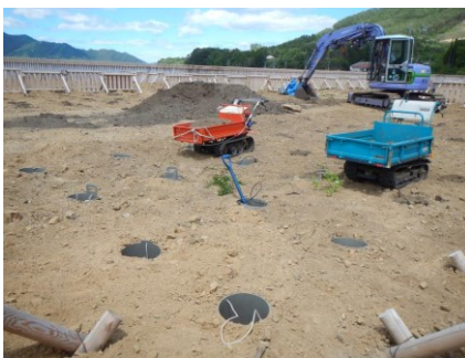
植穴への客土(黒土)の混入
