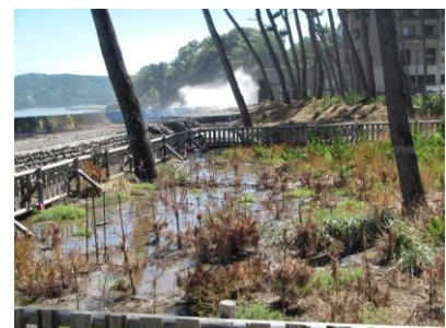
植栽4年後(H28. 9. 9)・滞水状況
