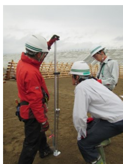
長谷川式土壌貫入試験の様子
