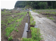
排水工(開渠排水)
