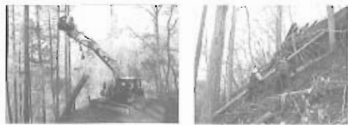
スイングヤードによる集材 荷揚げ手（2名）の作業
