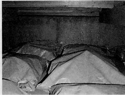
写真2 床下に入れた木炭の様子
