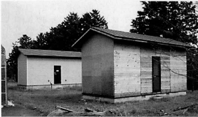
写真1 テストハウス外観 (手前：布基礎工法奥：基礎断熱工法)
