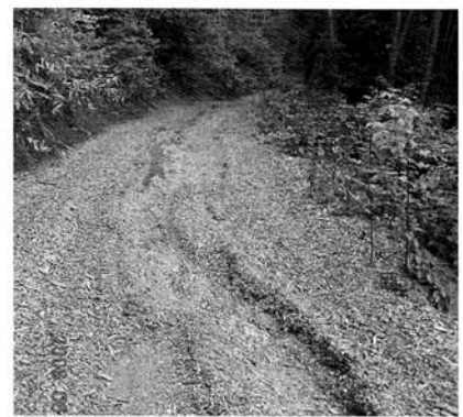
写真4 木材チップ路盤の流亡 (時間最大雨量 24mm)
