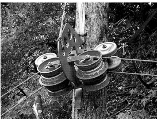
写真-1 中間サポーターの設置
