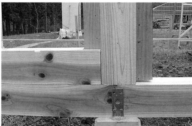
写真-2 東屋に一段目の壁材を落としこんだ状況
