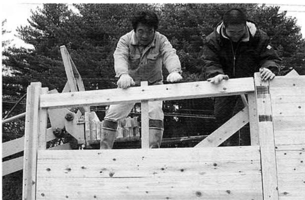
写真-4 壁材の落とし込み作業
