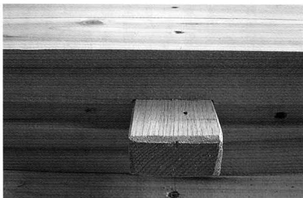
写真-3 壁材を緊結するダボ材
