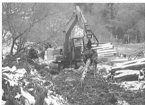
作業ポイントでの プロセッサ造材作業
