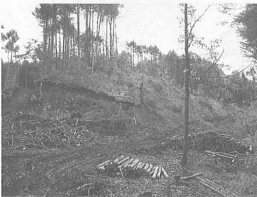
作業路を開設し、フォワーダで搬出
