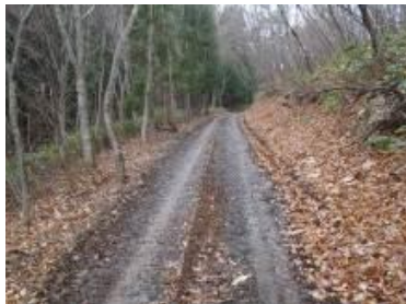
幹線の作業道
