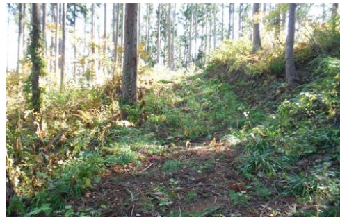
【波形勾配により雨水を分散】
