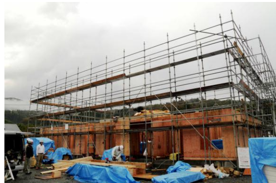
図-2 施工中の賃貸アパートの全景(1階の外側の壁が立ち上った状況)
