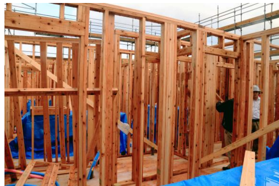
図-1 スタッド材(間柱)等にズギを利用した施工
