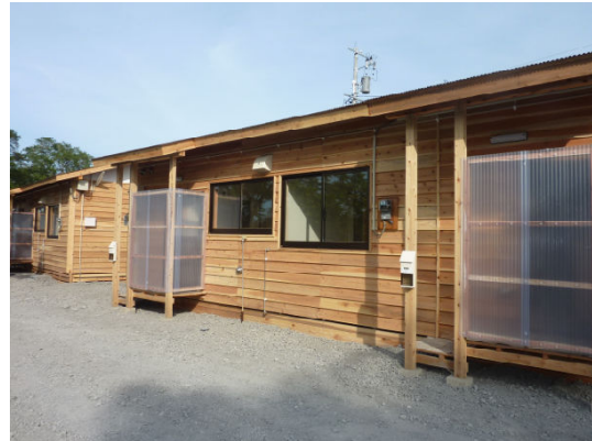
写真1 仮設住宅の概観(外壁スギ)
