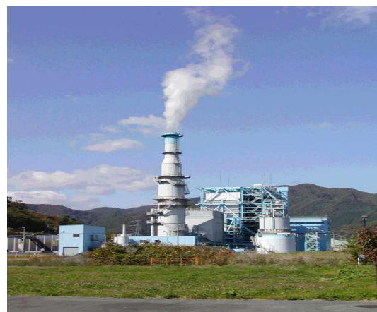
木質バイオマス石炭混焼発電施設
