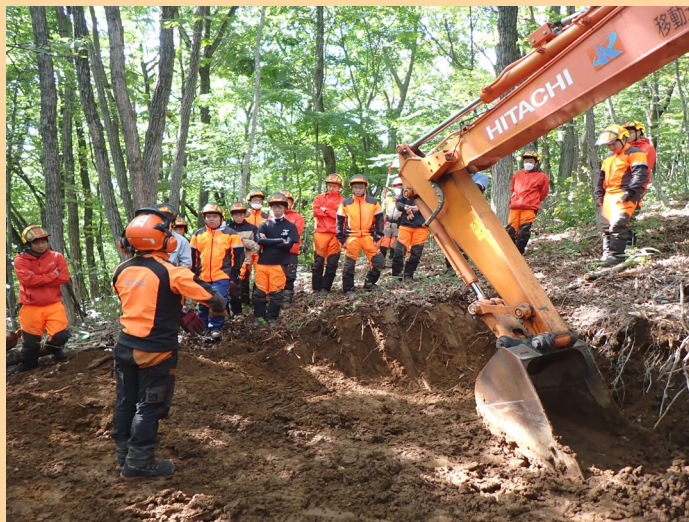
森林作業道の作設
