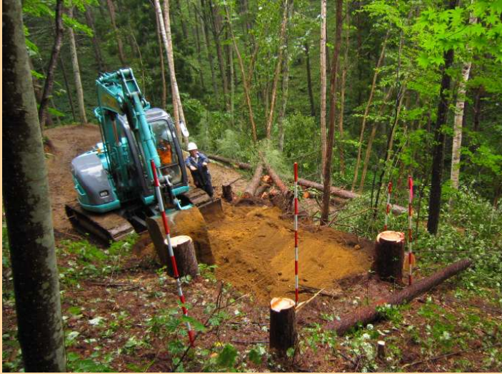
森林作業道の作設
