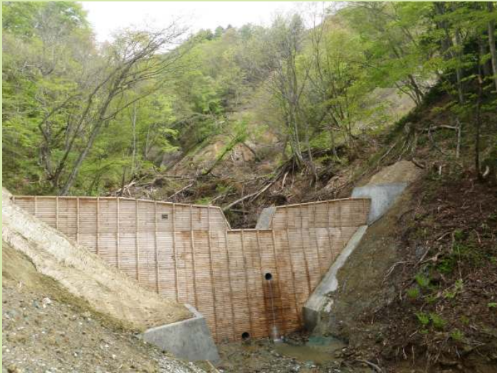
木製型枠式の治山ダム
