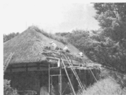
「差し茅」 民家の屋根補修
