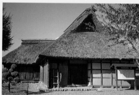
及川家住宅（北上市） 幕末。外観は南部曲り屋。妻入り。
