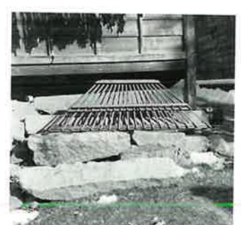
783 ノート情報：花籠の屋根 朴ノ木製 春慶塗 タルキは18本 二段につけてある。
