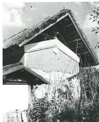
向って左) 095 裏面情報：クラ(土蔵)クラの鉢巻きと草葺屋根とのアキが大きい。稲瀬村大字稲瀬宇山岸 KT家 母家の南に在り、其入口は母家の入口と相対している。24-7-17
