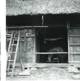
721 ノート情報：曲家 K氏(屋号「川向い」)の家。廊部分のオウギヒラに煙出しがついてゐない。
