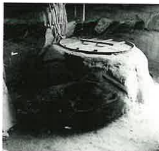
651 ノート情報:トナガマ 土製のカマの高さ約1尺8寸54cm ニワの隅にあり。豆腐用や味噌用の豆を煮る。鐵釜は軽米製 径2尺45 73cm 深約1尺 30cm
