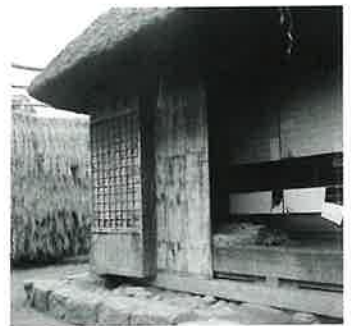
722 ノート情報：戸袋と雨戸 雨戸は縁側よりも下まで届いてゐる
