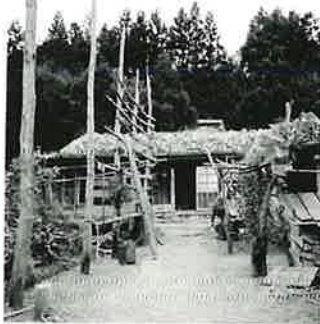
647 ノート情報:家の正面 屋根はイシヤとよぶ。マサの上に石をのせる。
