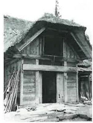
072 裏面情報：切家の玄関二階(藁などを置く)の窓は元は下部欄間と同じくサマコ(堅格子) 胆沢郡若柳村下嵐江 T家 24-5-19
