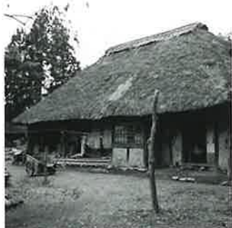
405 裏面情報：水沢市福原小路 G家南面 凸出部の窓は硝子に改造され縁側の西端は板でふさがれた。33-11-1
