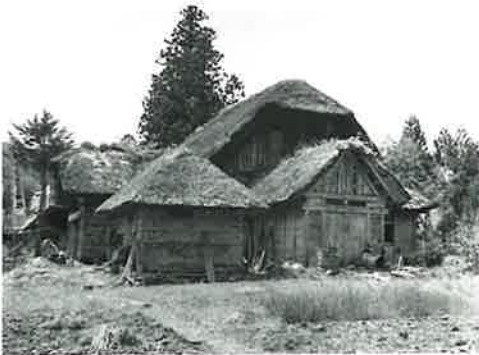
073 裏面情報：母家東面の切家 張出ている部分は水屋(井戸より)。その左は厩。母家の南に張出ているのは玄関(同じく切家なり) 胆沢郡若柳村下嵐江 T家 24-5-19
