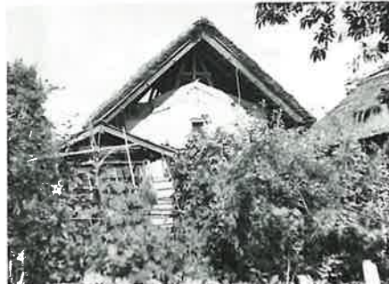
向って左) 095 裏面情報：クラ(土蔵)クラの鉢巻きと草葺屋根とのアキが大きい。稲瀬村大字稲瀬宇山岸 KT家 母家の南に在り、其入口は母家の入口と相対している。24-7-17
