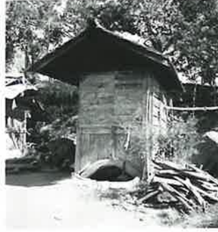
向って左) 427 裏面情報：小正月の屋根葺三枚戸 カノコダテ 大東町曾慶*** S家 34-4-2 中央) 428 裏面情報：ニワのクド 左端のクドにはセンパンがかかっている 右端の味噌タキ釜のかかっているクドは見えない。その右後ろにウシ柱とカマガミ 大東町曾慶*** S家 34-4-2 向って右) 429 裏面情報：地覆 風呂と小便所を含む小屋の側面の汲取口に弧形材を用いてアーチ口となす この弧形材を地覆という 母屋の前にあり 大東町曾慶 F家 34-4-2
