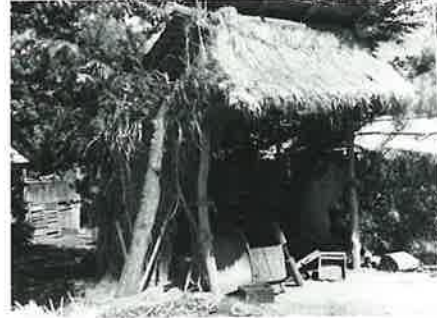
向って左) 095 裏面情報：クラ(土蔵)クラの鉢巻きと草葺屋根とのアキが大きい。稲瀬村大字稲瀬宇山岸 KT家 母家の南に在り、其入口は母家の入口と相対している。24-7-17
