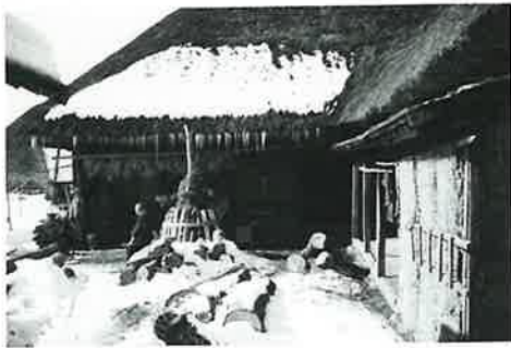
232 裏面情報：タテギ 東から見る 内川目 金沢 SS家 28 旧1-1
