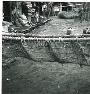
624 ノート情報:手モッコ 縄製 柄は杉(全長200cm) 縄あみの部分の長さ128cm
