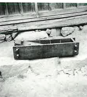
654 ノート情報:フクロアケ(竹カゴ)図のように仕掛けたフクロアケに麻袋を入れ、豆の煮汁を充たし、適当のときフクロアケを上にくくと袋だけ残る。その袋を押してしぼると汁が下のハギリに溜る。熱いのでメンボウを使って袋を押す。
