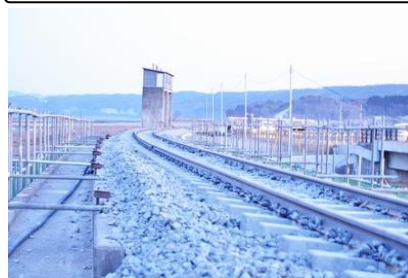
野田村 復旧工事が進む三陸鉄道北リアス線 H24.2.20
