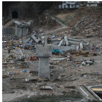
線路が流出した島越駅付近
