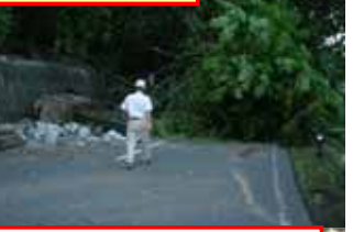
342号: 白崖 全面通行止 (土砂崩落)
