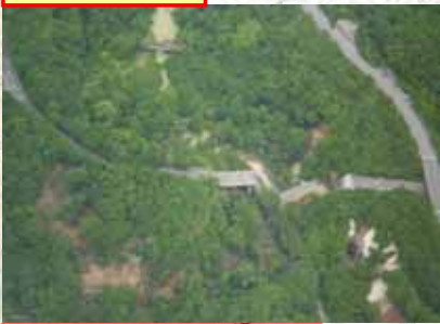
342号: 祭時大橋 (落橋)
