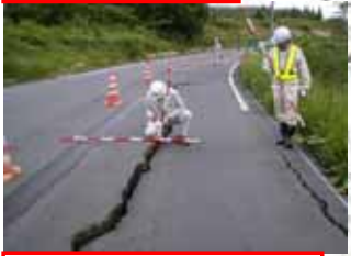
107号: ゆだ高原駅付近 片側交互 (路面沈下)
