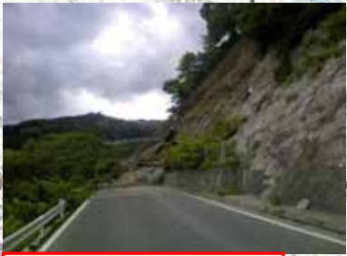
397号: 石淵トンネル東側
