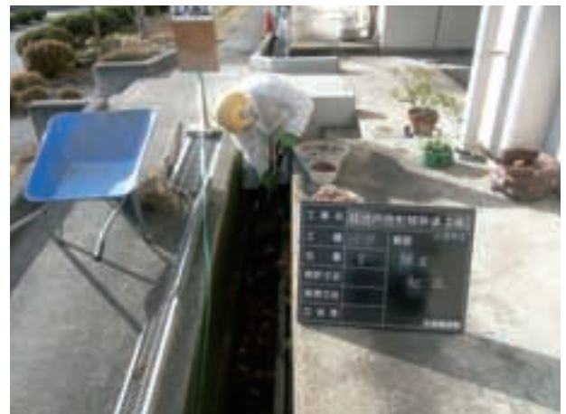
除染作業の様子①
