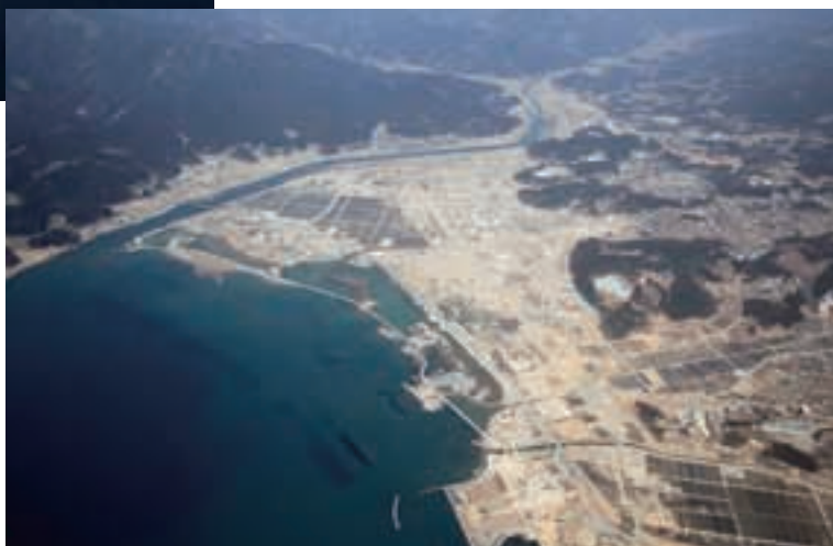
平成24年4月(応急復旧実施後)
