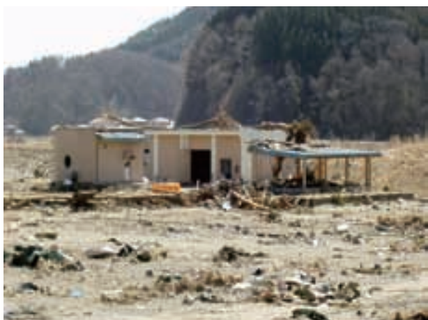
陸前高田市竹駒第1水源(浄水場)被災状況
