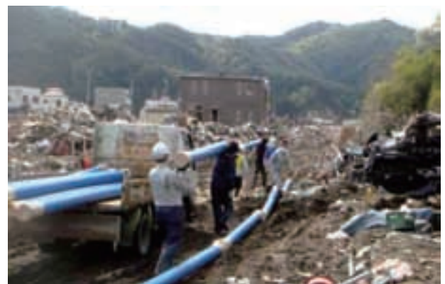
釜石市鶴住居仮配水管設置状況
