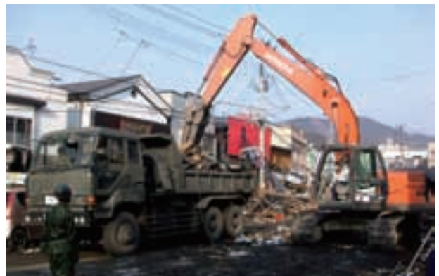
釜石市内における道路啓開作業
