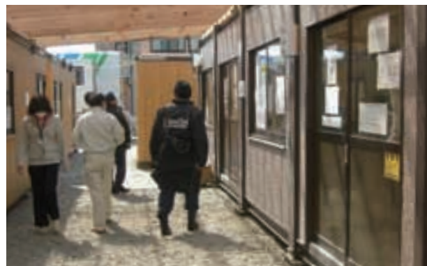
ユニットハウスにより設置された陸前高田市仮設庁舎
