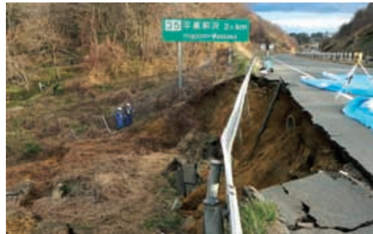
崩れた東北自動車道の路肩 写真提供／岩手日報社
