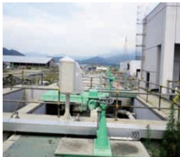
大船渡浄化センター1系水処理(生物処理) 〈復旧中(平成 24/8/29)〉
