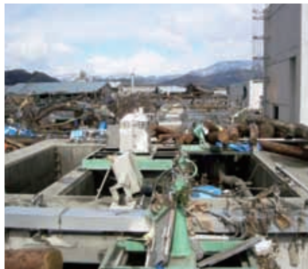
大船渡浄化センター1系水処理(生物処理)〈復旧前(被災直後)〉
