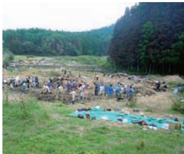
陸前高田市におけるボランティア活動(がれき撤去)の様子
