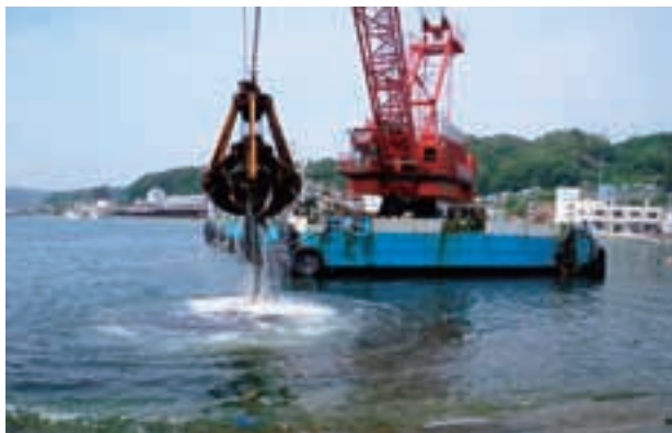
宮古港における海上啓開作業
