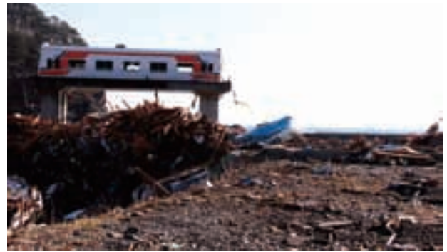
がれきが散乱する平井賀地区。左に見えるのは三陸鉄道をかたどった水門の管理棟
