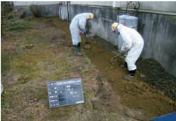
除染作業の様子③
