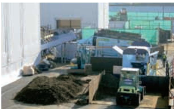
久慈地区(野田村)二次仮置場に設置された精密分離機
