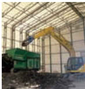
久慈地区(野田村)二次仮置場における破碎機への投入状況
