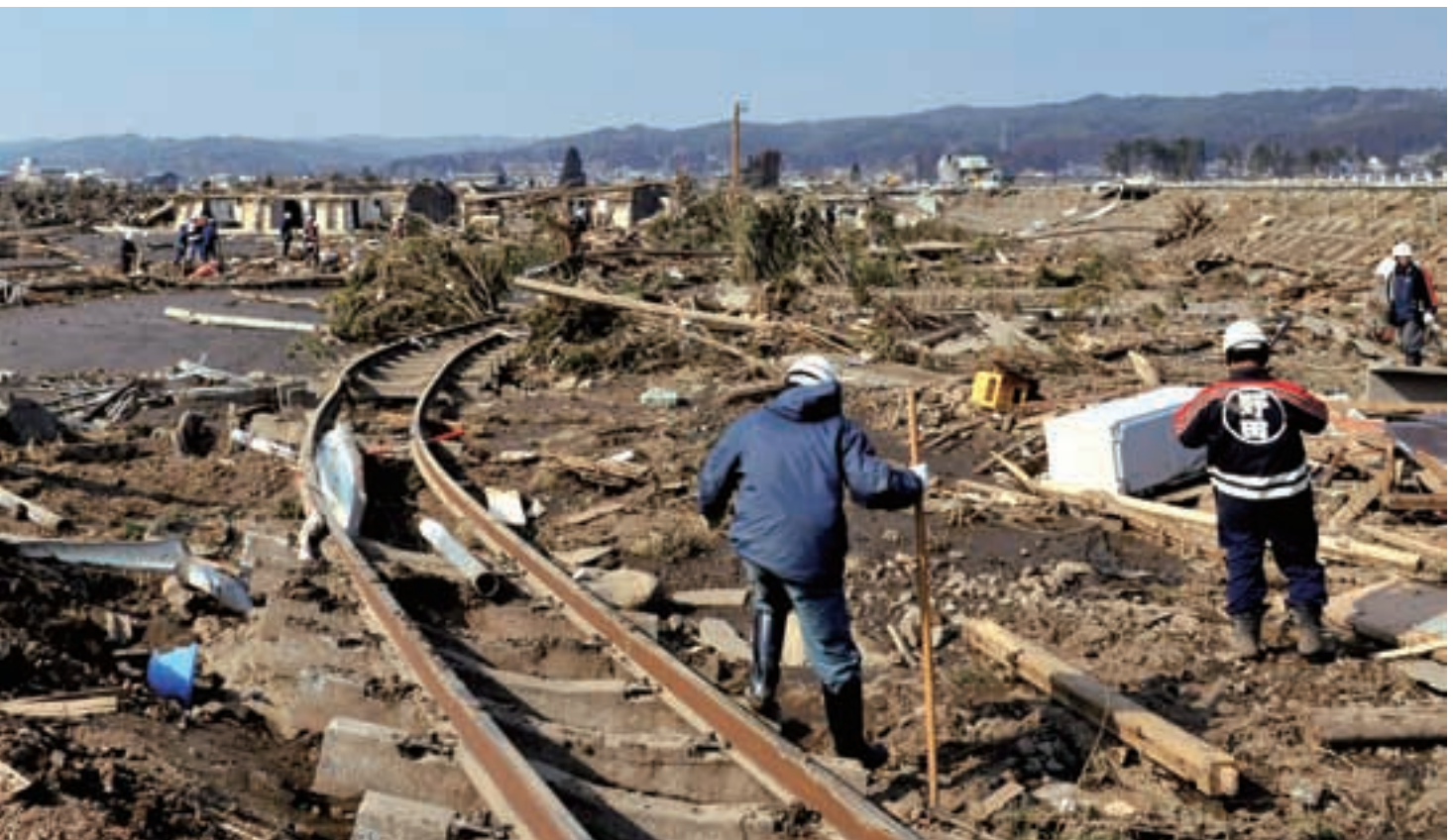
津波によって三陸鉄道も久慈市から野田村にかけて寸断された 写真提供／岩手日報社
