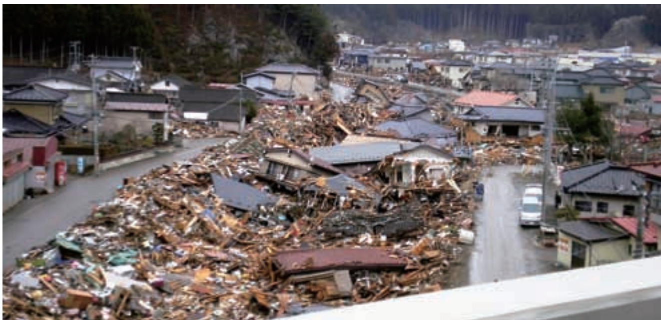
被災直後の釜石市片岸地区の状況
