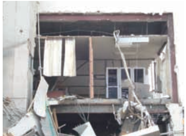
被災した大槌町役場2階に残された各種システムのサーバー
