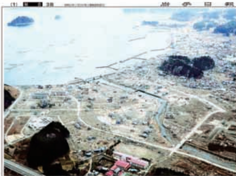
東日本大震災発生直後の岩手県大船渡市。津波で壊滅した街並い。津波の被害は、津波の到達した沿岸部から、内陸部へも広がった。
