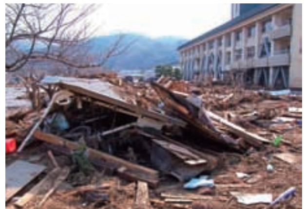
県立宮古工業高校の被害状況
