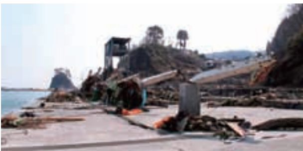
漁具が流され、建物も崩壊した島越地区の漁港。90度に押し曲げられた鉄柱が津波の威力を物語る
