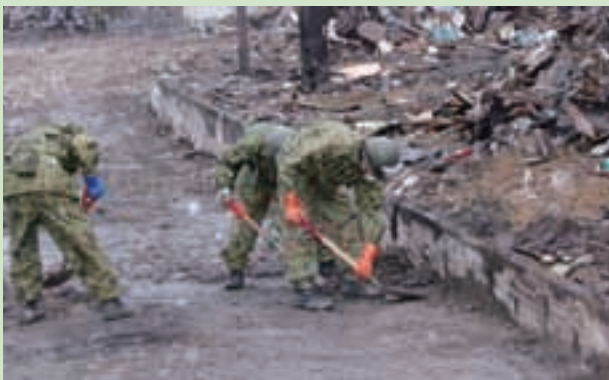
自衛隊による道路啓開
