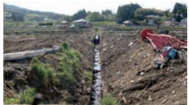
応急工事によるがれき撤去後
