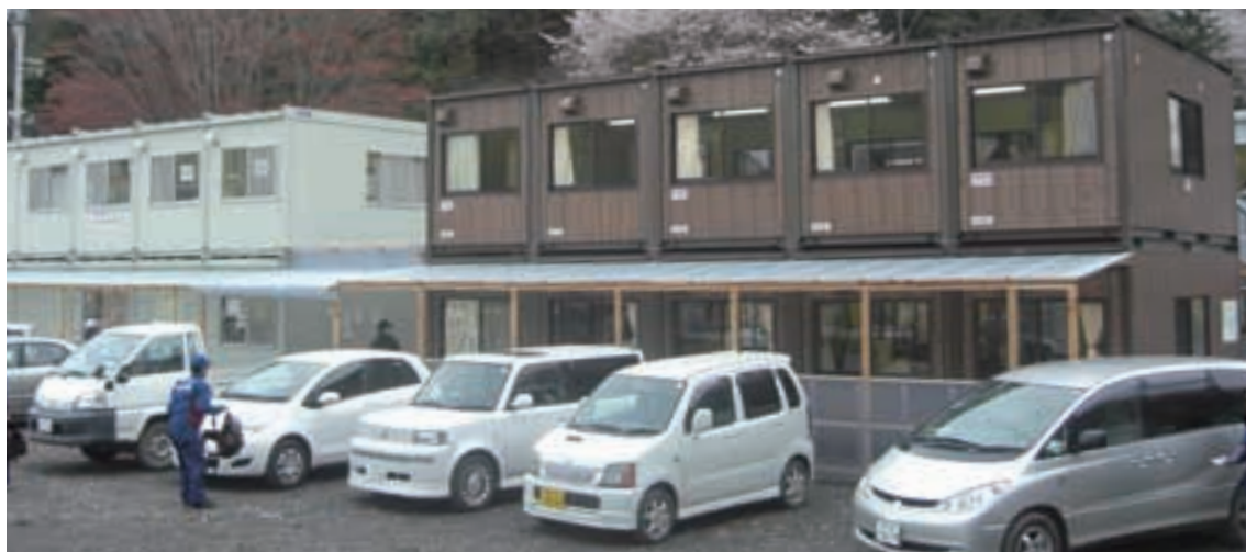
ユニットハウスにより設置された大槌町仮設庁舎
