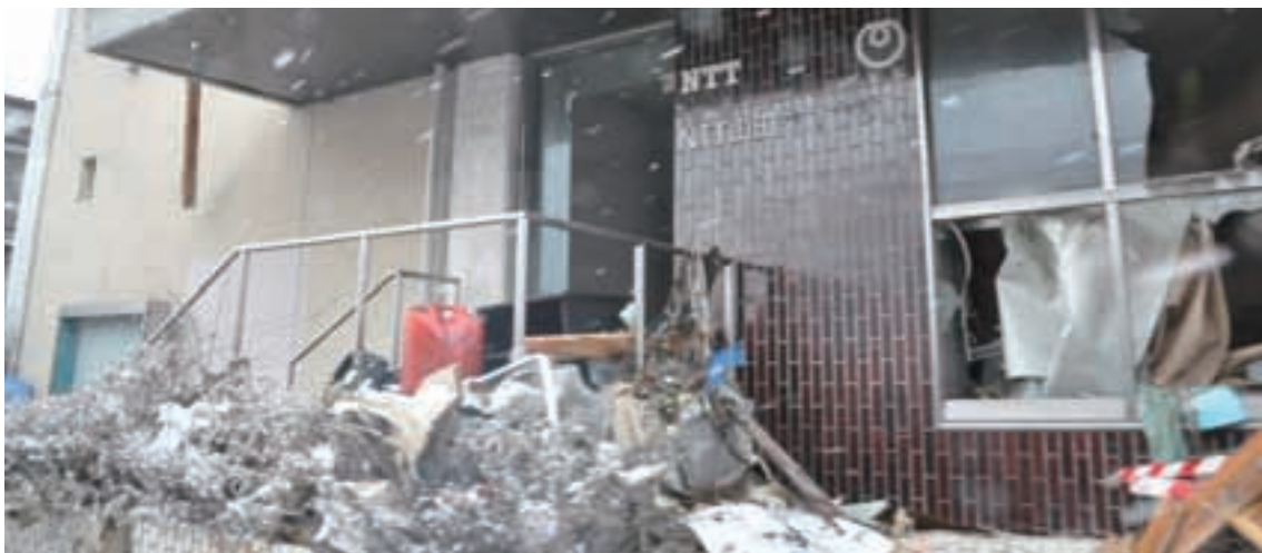
被災した NTT 山田ビル
