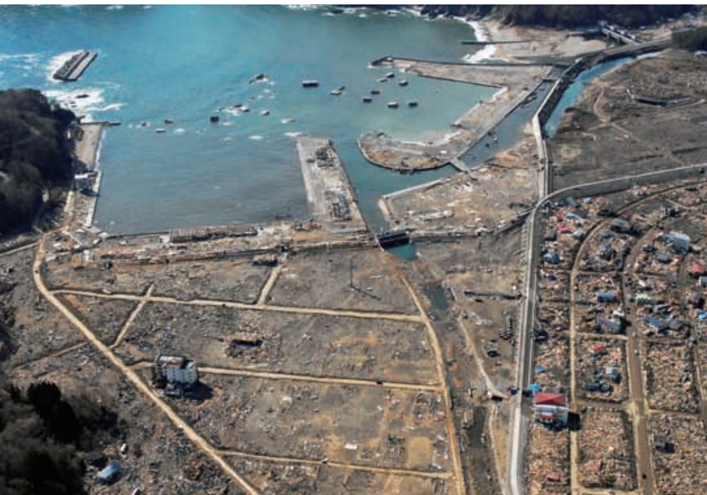
防潮堤が崩壊した宮古市田老地区 写真提供/岩手日報社
