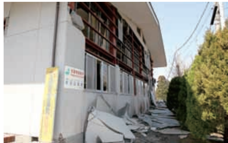
外壁が崩れ落ちた萩荘公民館（一関市）
