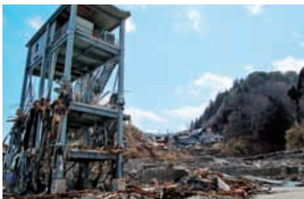
漁協施設などが被害を受けた田野畑村島の越漁港 写真提供/岩手日報社
